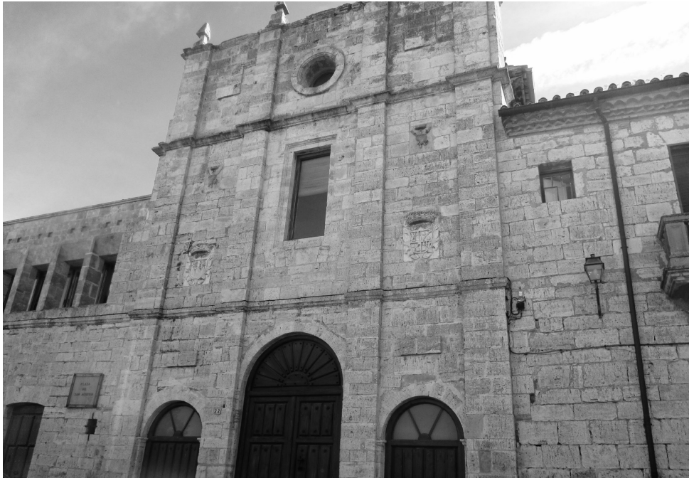
Fachada de lo que fue el convento de San Agustín en Toro, en el que se encontraba la iglesia de San Pelayo donde fue bautizado Antonio Basilio Gutiérrez Ulloa.
